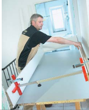
02 STIL DEN MONTEREDE RAMME FORSIGTIGT IND I MURÅBNINGEN.
