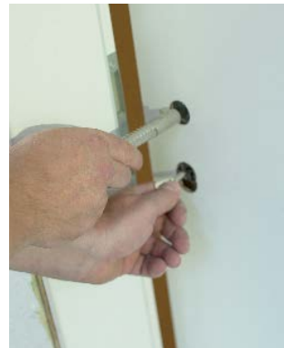
06 PRØVEM ONTERING AF DØRBLAD.
