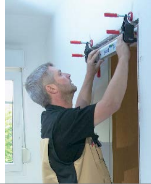
03 KONTROLLER DEN LOD OG VANDRETTE JUSTERING AF RAMMEN.
