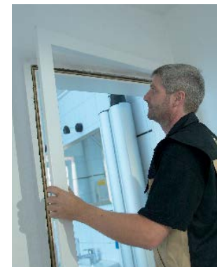
07 MONTER INDFATNINGER UDEN LIM.
