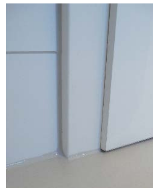
09 FORSEGLING MED SILIKONE SÅFREMT DETTE ØNSKES
